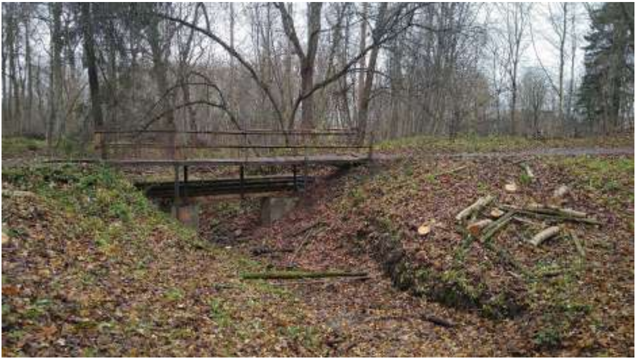
Фото 3. Вид на существующий мост и участок проектирования с южной стороны ручья. Общее состояние откосов ручья.
