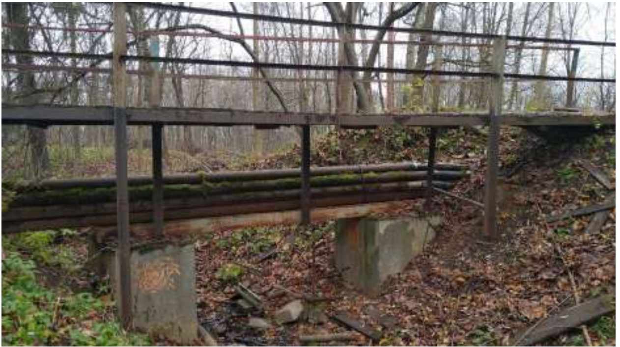
Фото 5. Аварийное состояние существующего моста. Кабели слаботочных сетей, уложенные через ручей в металлических гильзах, опираются на бетонные основания.
