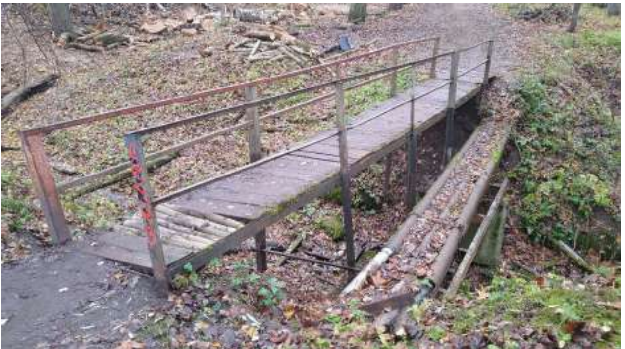
Фото 4. Вид на существующий мост и кабели слаботочных сетей, проложенные в металлических гильзах.
