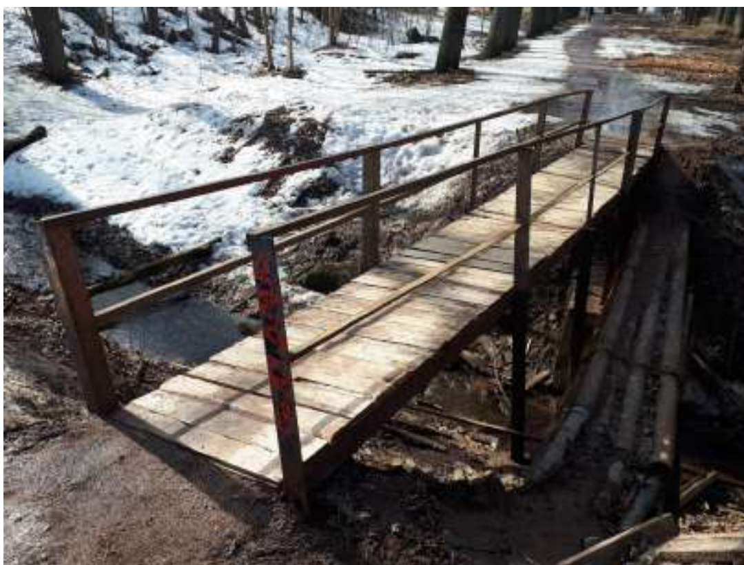
Фото 4. Приоратский парк. Вид на существующий мост и кабели слаботочных сетей, проложенные в металлических гильзах. Полетайкин В.В. 24.03.2021.
