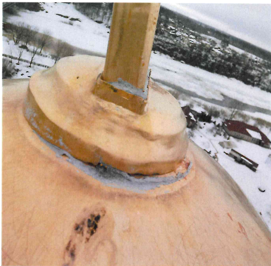
Рис. 3. Деформация вертикальной стойки креста в месте заделки.
