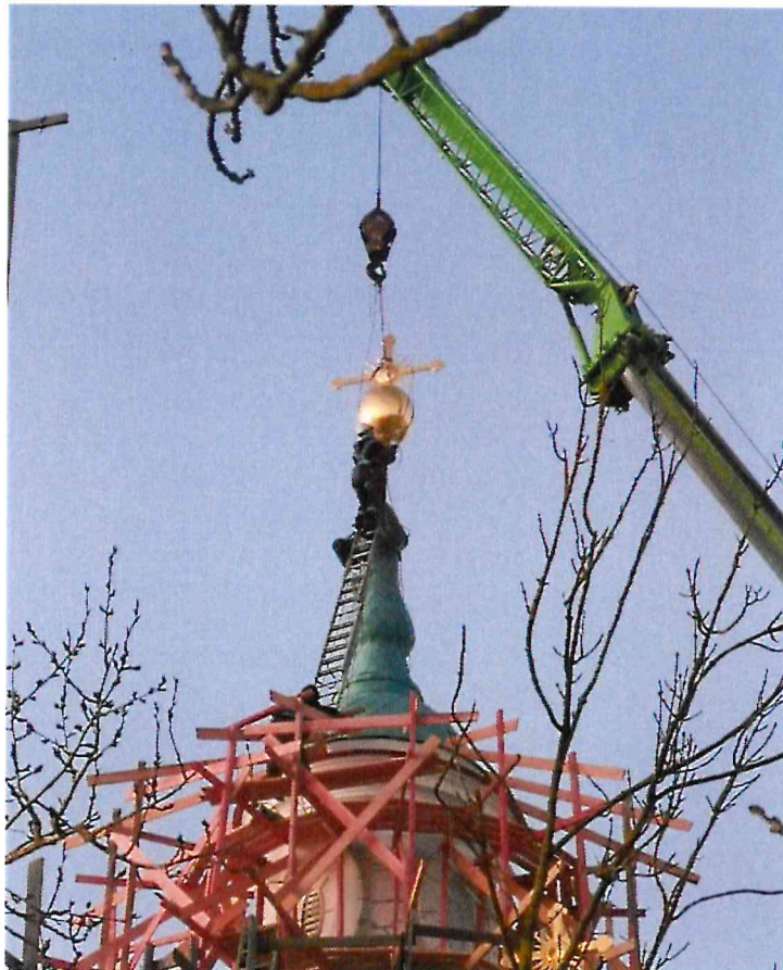
Рис.2. Процесс демонтажа медновыколотного креста.
