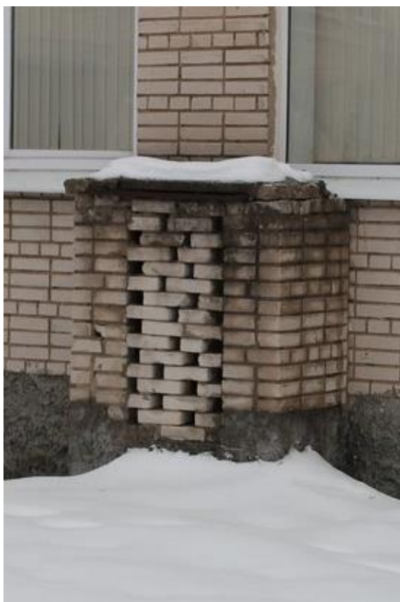
Фото 71 – 73. Воздухозаборные шахты (вспомогательное сооружение)
