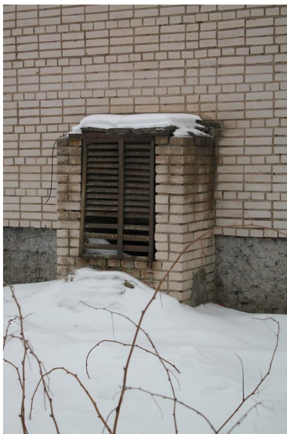
Фото 71 – 73. Воздухозаборные шахты (вспомогательное сооружение)
