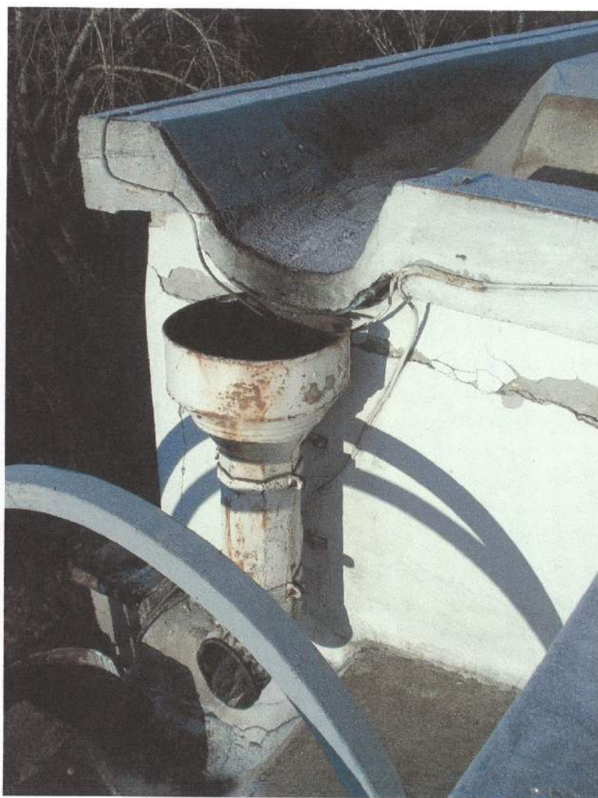
Фото 18. Водоприемная воронка юго-западной повышенной части кровли с восьмигранной водосточной трубой.
